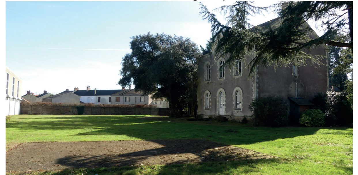
Vue extérieure 2 - la façade nord du presbytère
