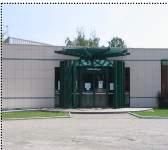
Médiathèque de Bouaye
